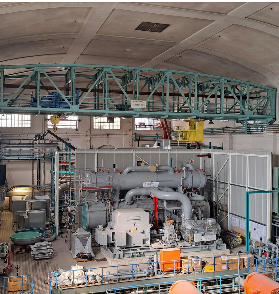
Die rund 225 Tonnen schwere Großwärmepumpe von Johnson Controls (hier während der Montage) wurde in die bestehende Maschinenhalle des EnBW-Heizkraftwerks integriert – bei laufendem Betrieb. (Foto: EnBW Stuttgart)
