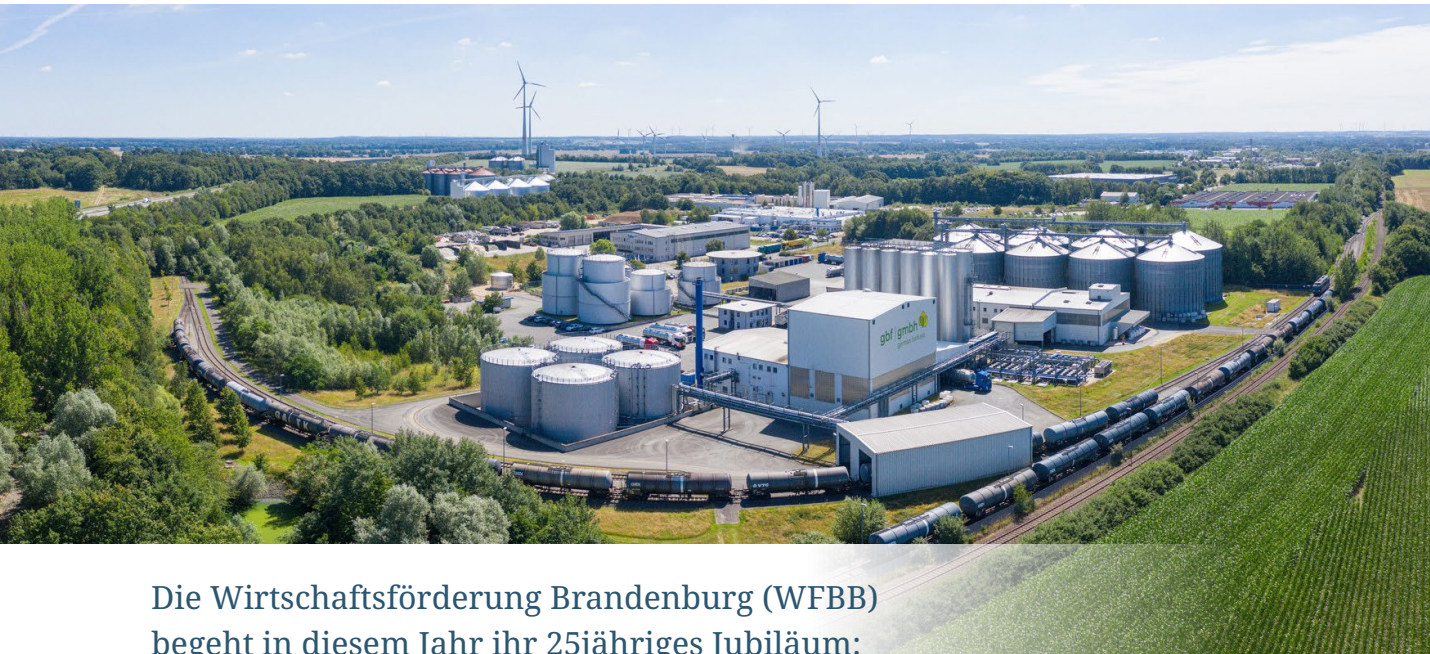
Gewerbegebiet Hagenwerder (Foto: WFBB)
