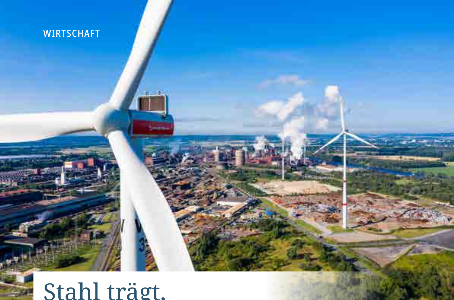
Windenergieanlage, Salzgitter Foto: SZAG
